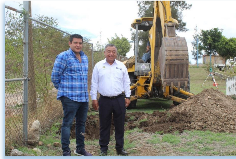
Figura 36 Colocación de la primera piedra de inicio de la construcción de la primera etapa de la barda perimetral.
