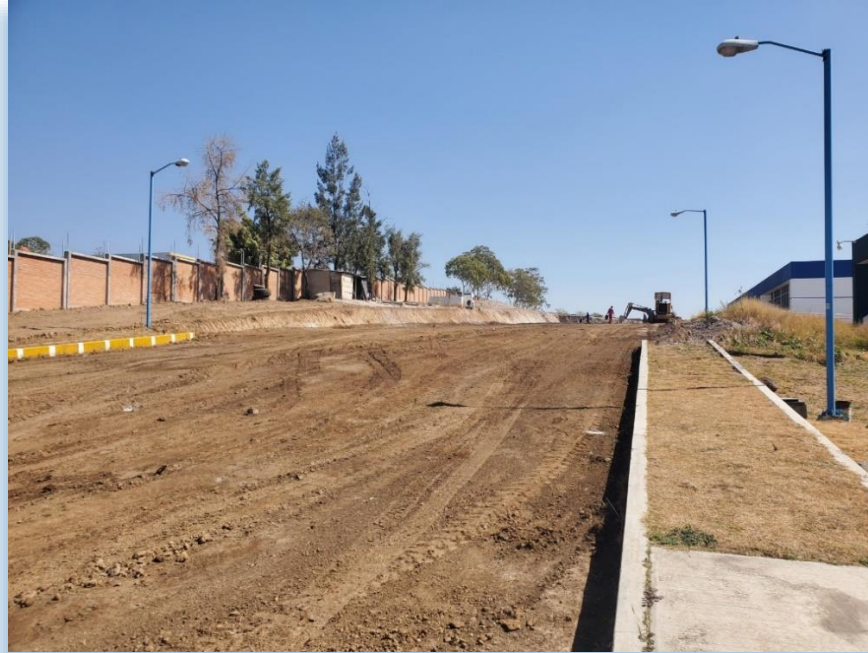
Figura 42. Construcción del estacionamiento del edificio H al K.
