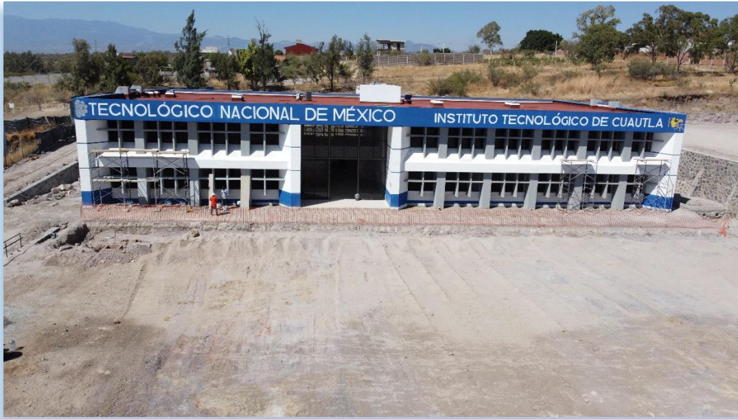
Figura 40. Inicio de la construcción de la Explanada Monumental del edificio K.
