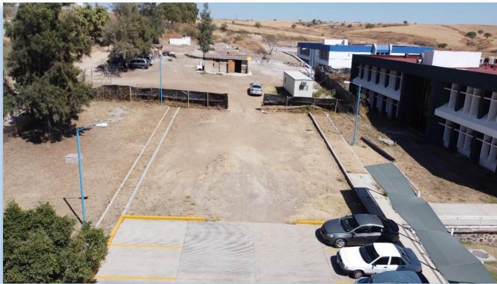
Figura 43. Antes de la construcción del Estacionamiento Magno del edificio H al K.
