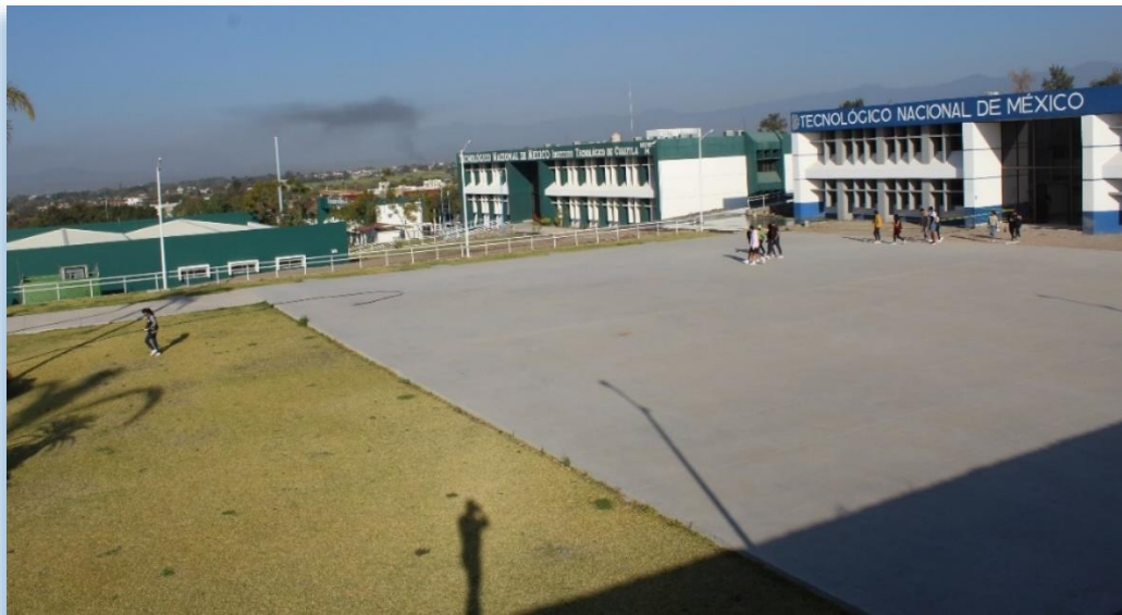
Figura 41. Explanada y jardín del Edificio K.
