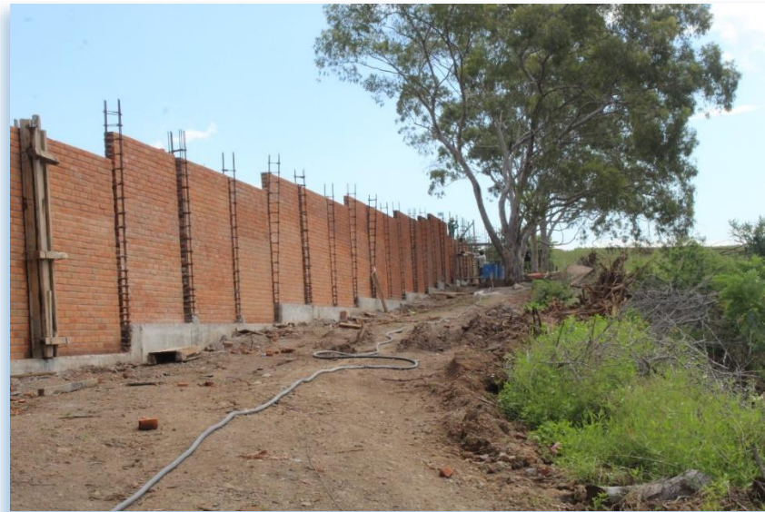
Figura 37. Construcción de la primera etapa de la barda perimetral.
